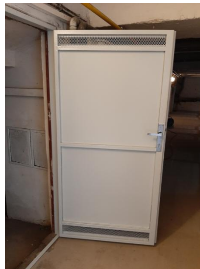
pohled dveře z vnitřní strany
